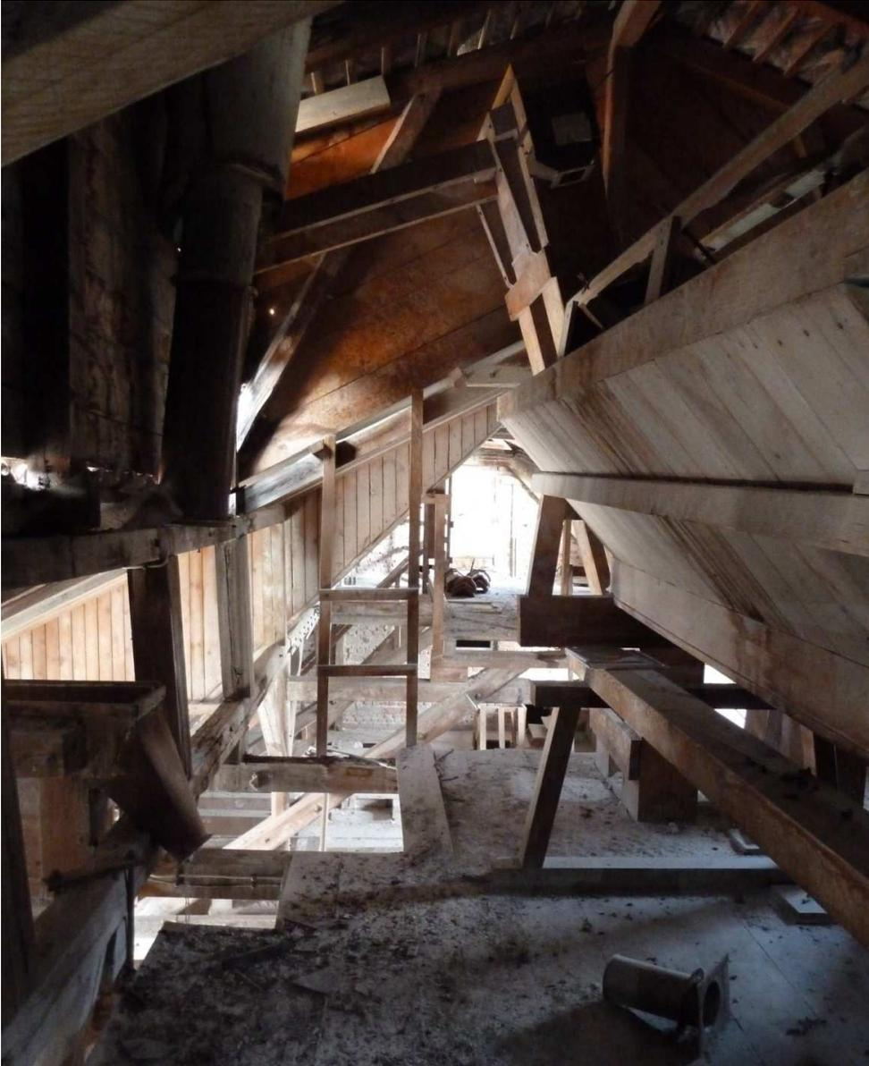
Abb.58: 4.OG – Ebene 3 ; Mahlkasten und Trichter<sup>88</sup>
