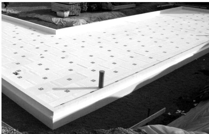
Abbildung 5 EPS Dämmplatten (Perimeterqualität) als lastabtragende Wärmedämmung kann nur bei einer Feuchtebeanspruchung nach Teil 4 der DIN 18195 eingebaut werden.
