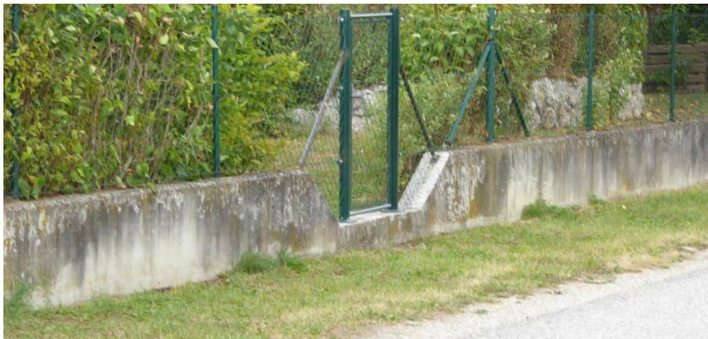
Abbildung 10 Das Bild zeigt eine nachträglich ausgeschnittenen Gartenmauer (erkennbar an der „frischen Schnittkante“ des Betons). Da hatte zwar gegen das Hangwasser, welches entlang der Straße geflossen ist, volle Schutzwirkung, aber gegen das Wasser, welches von der Hinterseite auf das Grundstück eintrat, staute die Mauer derart hoch, dass dadurch das Gebäude abermals geflutet wurde. (Quelle der Bilder: © EPZ)
