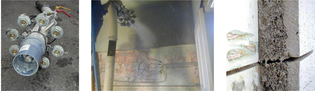
Abbildung 1 Sprühkopf - Aufsprühvorgang – Innendämmsystem
