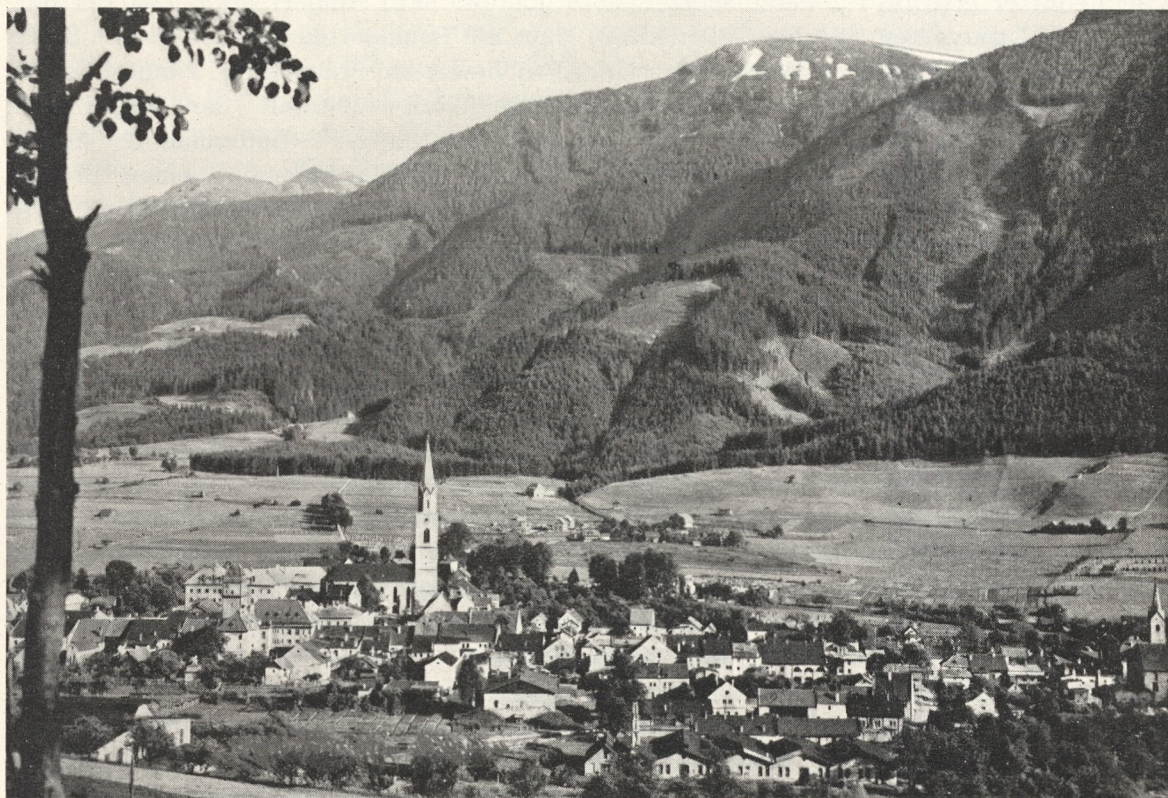
Abb. 105. Stadt Rottenmann mit der Chorherrenkirche. Ganz rechts die Spitalkirche
