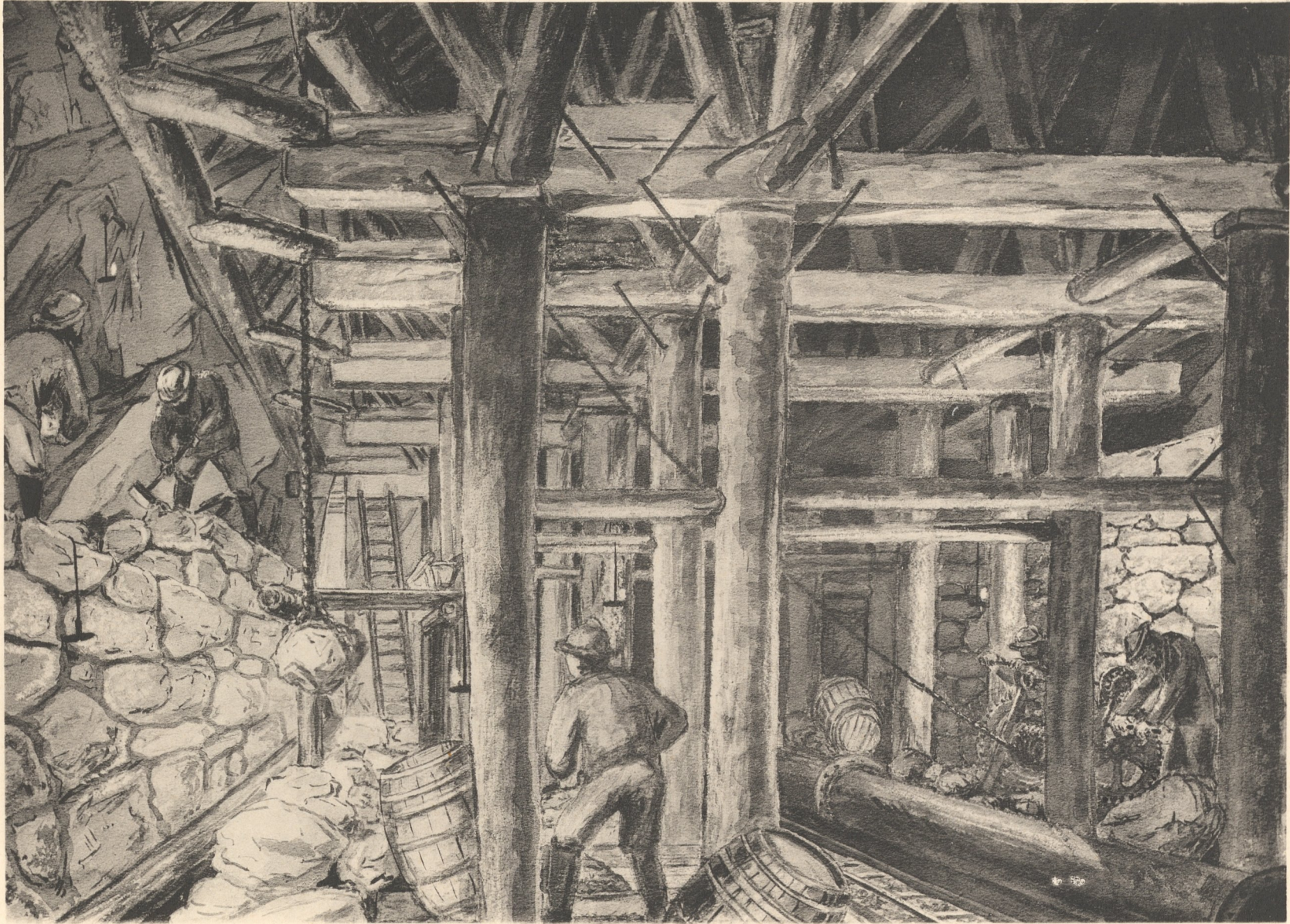
Mauerung des Widerlagers.
