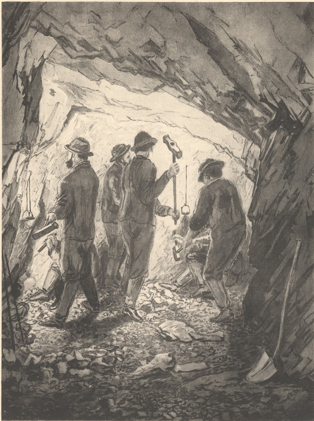
Handbohrung vor Ort auf der Südseite.
