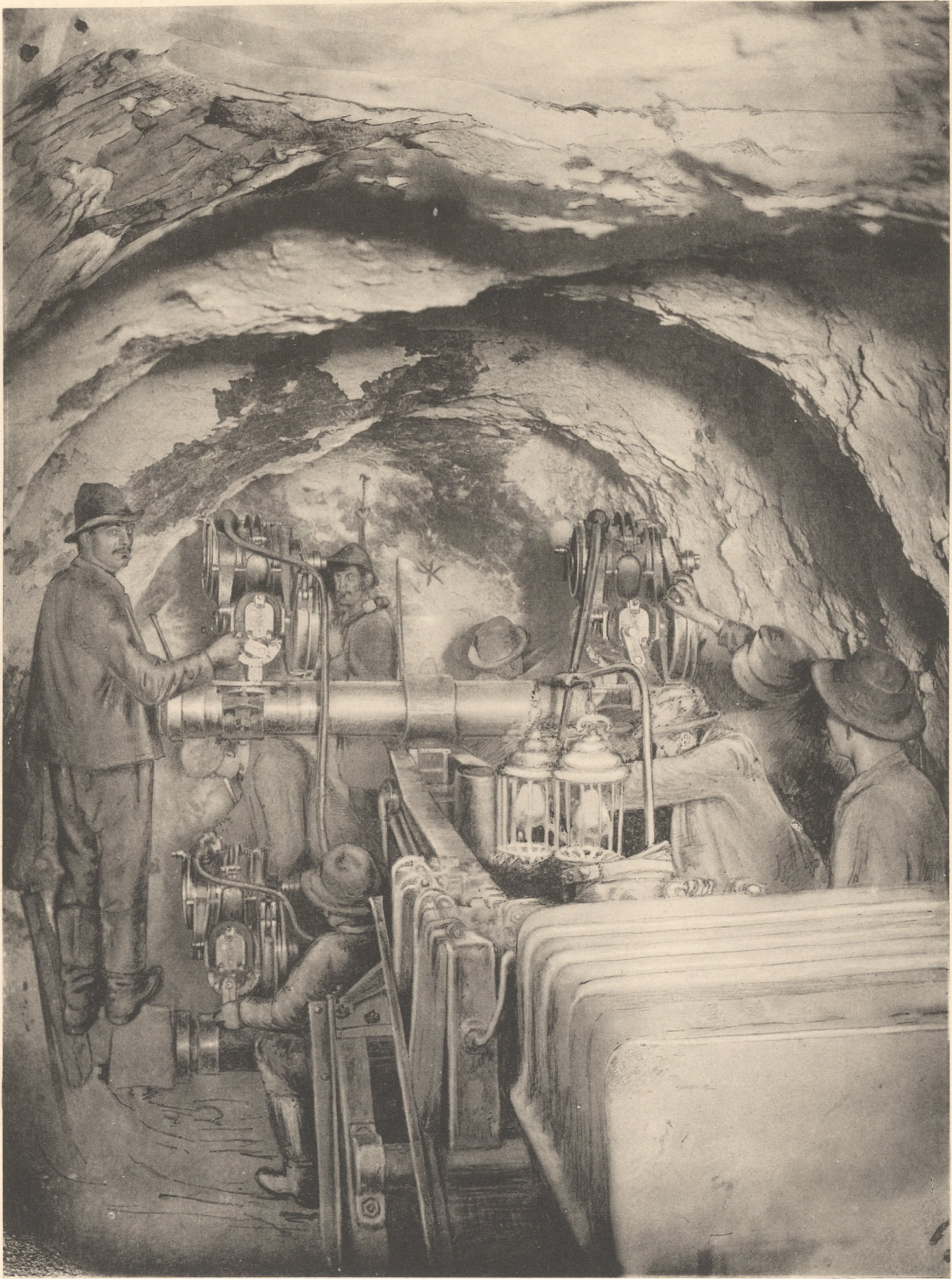
Maschinelle Bohrung vor Ort auf der Nordseite.
