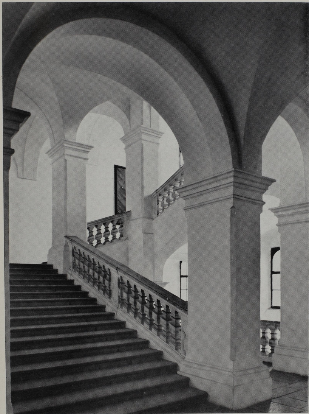
115. Prunkstiege Tannhausen, 1723 erbaut von Joseph Carlon
