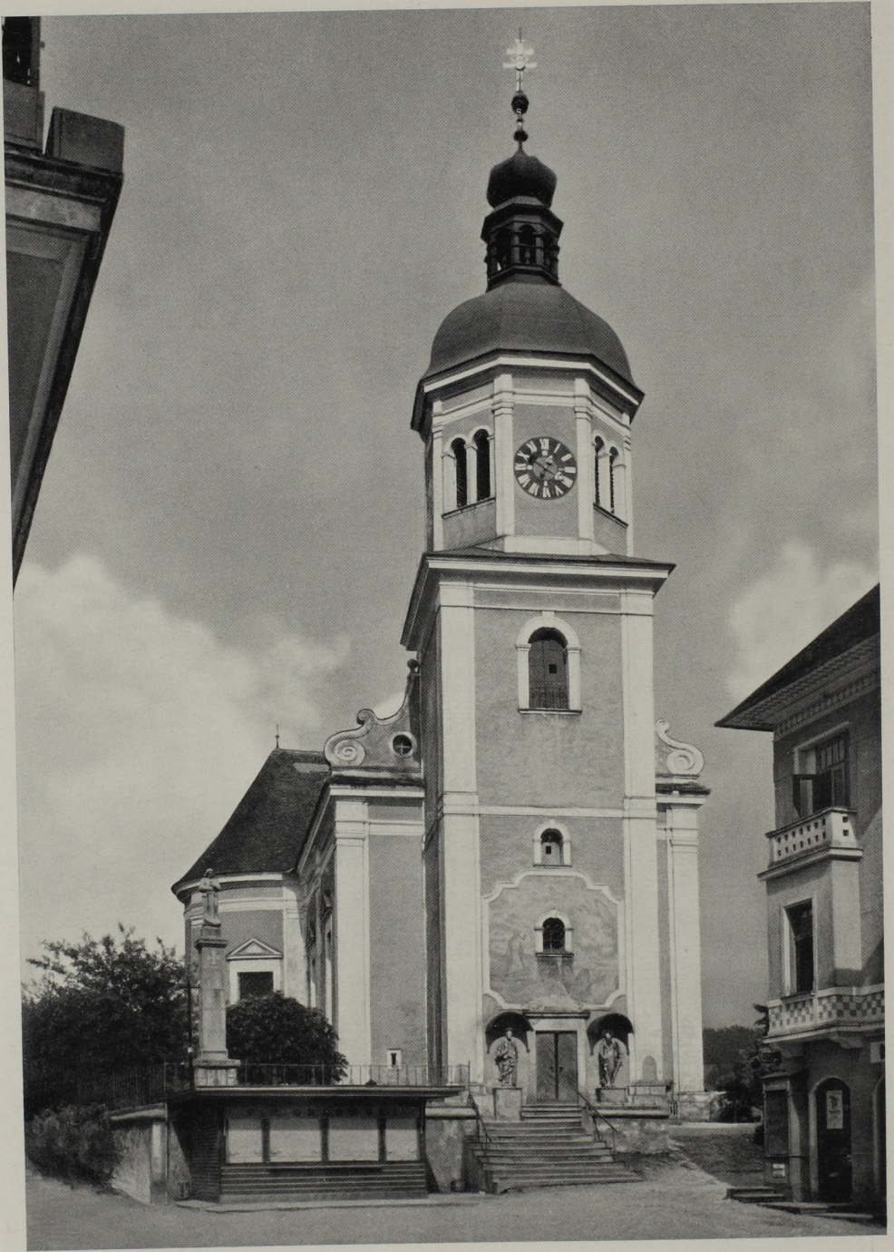
112. Dekanatskirche Birkfeld, 1709—1715 erbaut von Remigius Horner
