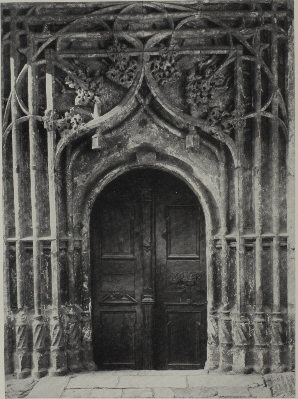
56. Südportal des Gösser Münsters. Erbaut um 1520
