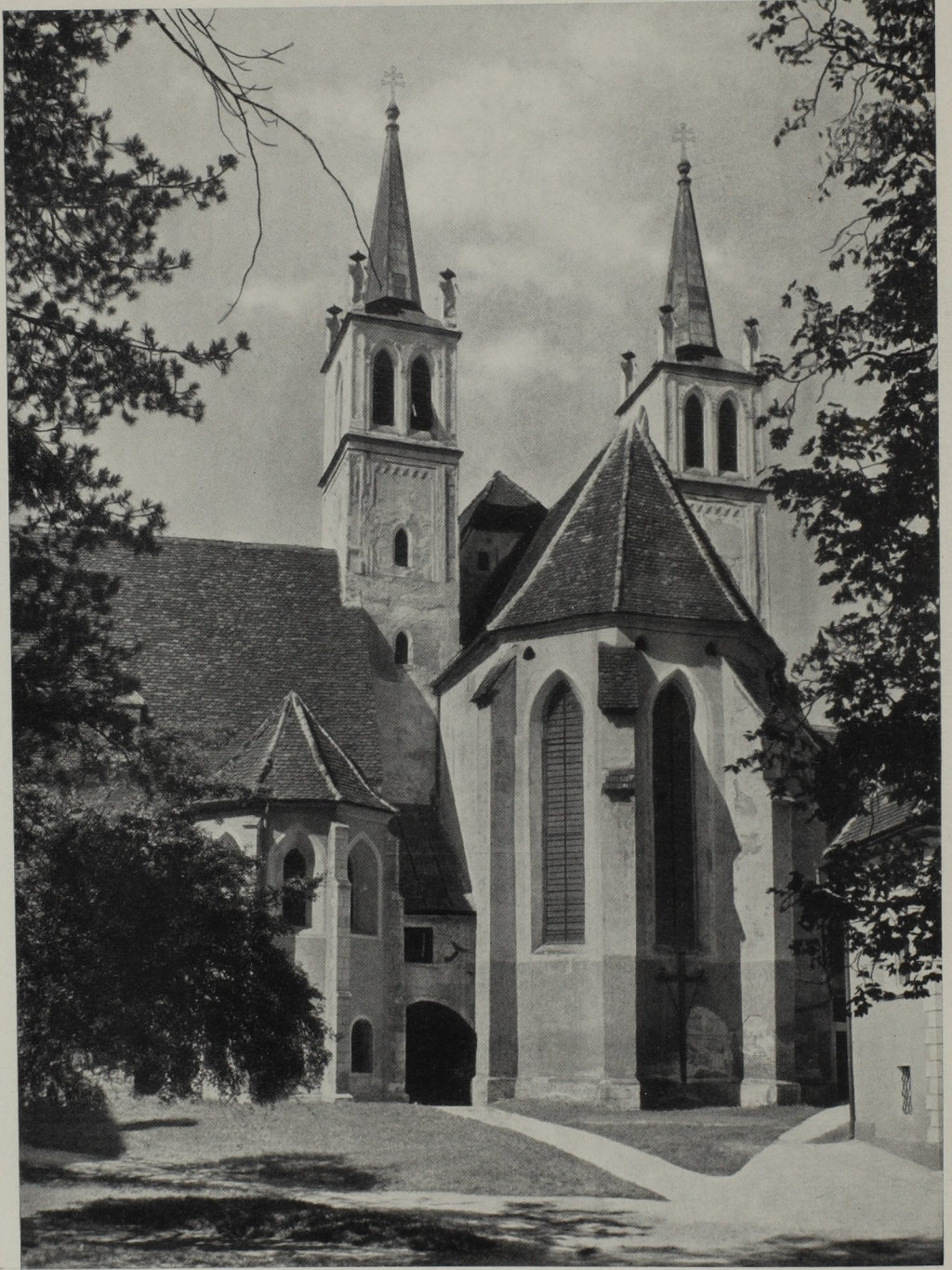
16. Kanonissenstiftskirche Göss. Chorbau errichtet 1338
