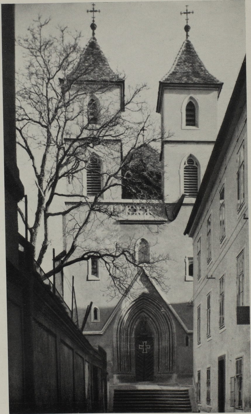
10. Maria am Leech. Portal erbaut um 1280, Türme um 1500
