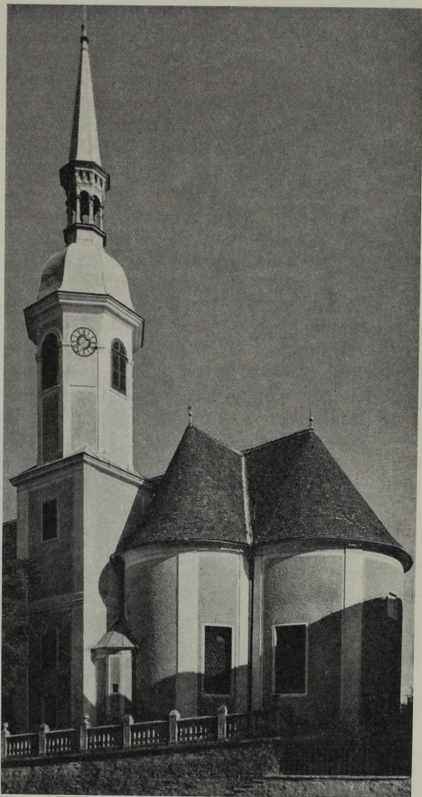
Abb. 251. Pfarrkirche Kaindorf, 1717 erbaut von Remigius Horner.
