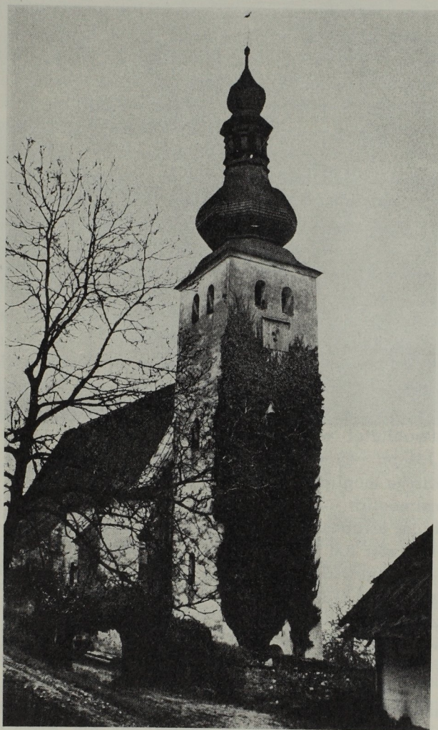
Abb. 210. Kirchturm von St. Johann am Kirchberg, 1658 erbaut von Blasius Sorger.
