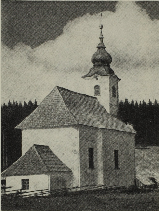
Abb. 171. Anton Liebfahrt: Pfarrkirche Glashütten, 1767—1770.
