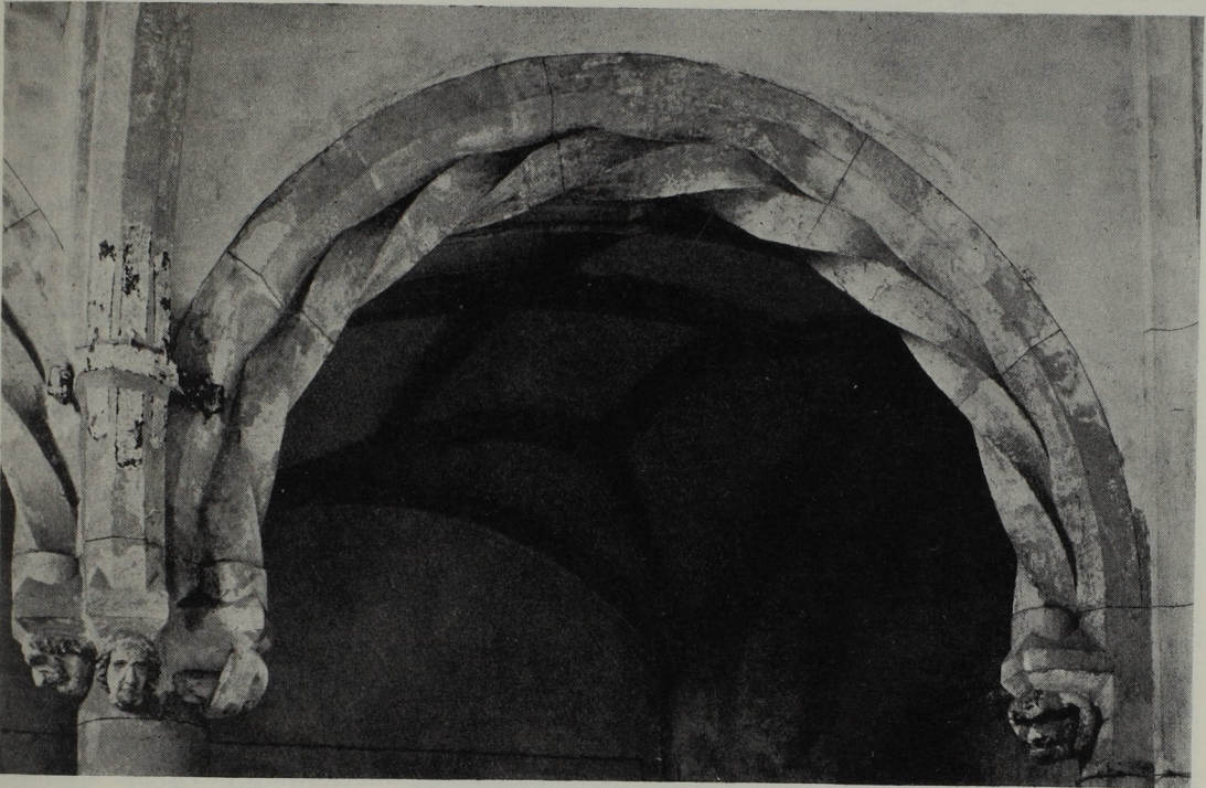
Abb. 157. Pfeilerbogen an der Orgelempore.
