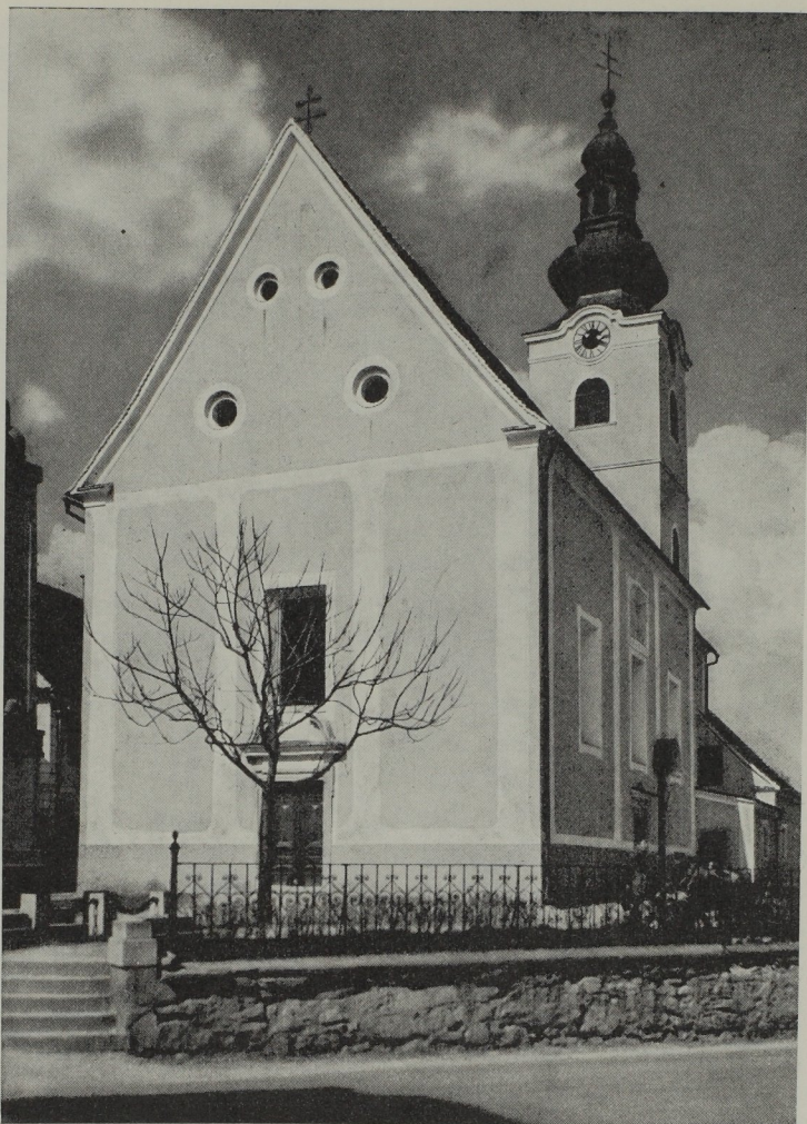
Abb. 105. Domenico Orsolino: Dekanatskirche Waltersdorf, 1690
