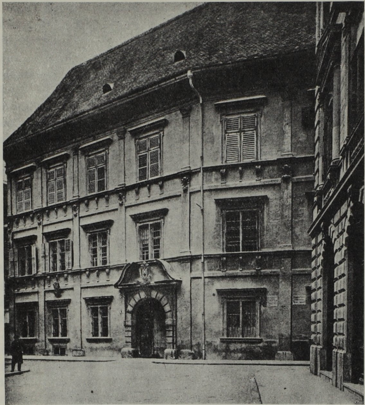
Abb. 91. Jacob Simonis: Vorauer Hof (um 1908 demoliert)
