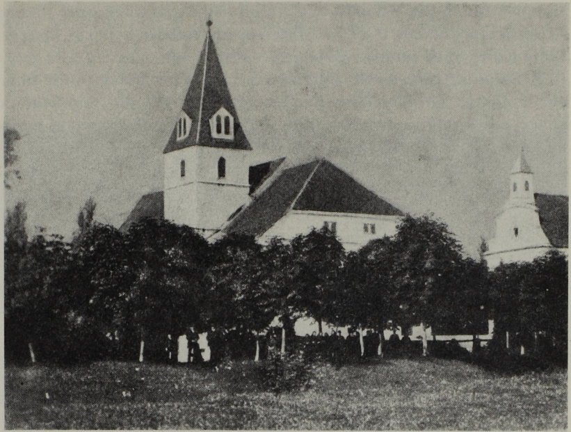
Abb. 242. Der Murecker Kirchturm vor 1888.
