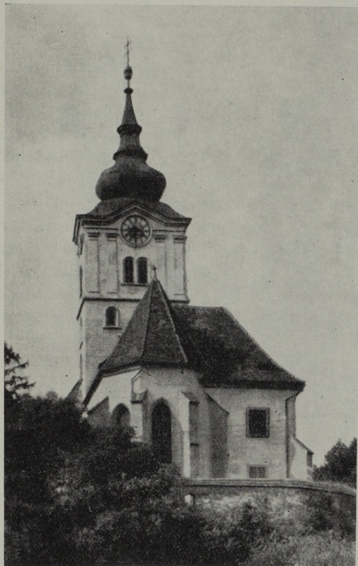
Abb. 136. Johann Georg Stengg. Kirchturm Straßgang.
