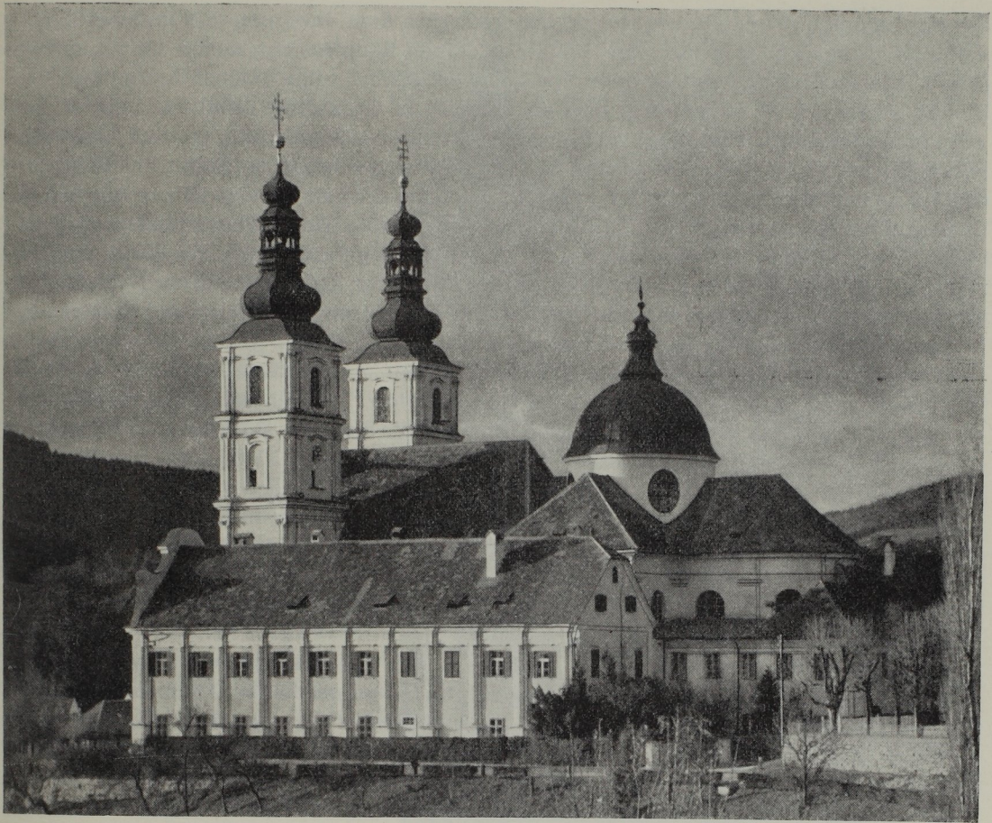
Abb. 133. Andreas Stengg: Mariatrost (Gesamtanlage).
