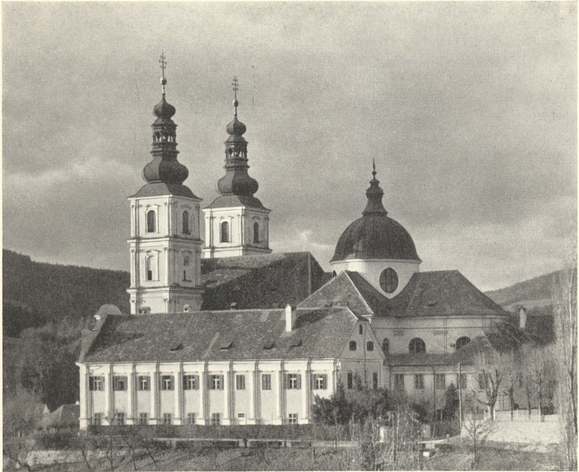
Abb. 79. Blick vom Südosten
