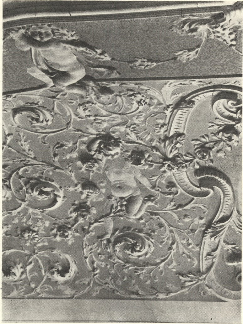
Abb. 56. Gewölbbestuck von Domenico Boscho
