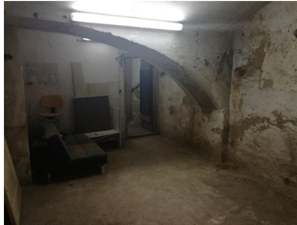
Abb. 3: Gewölbedecke im Keller
