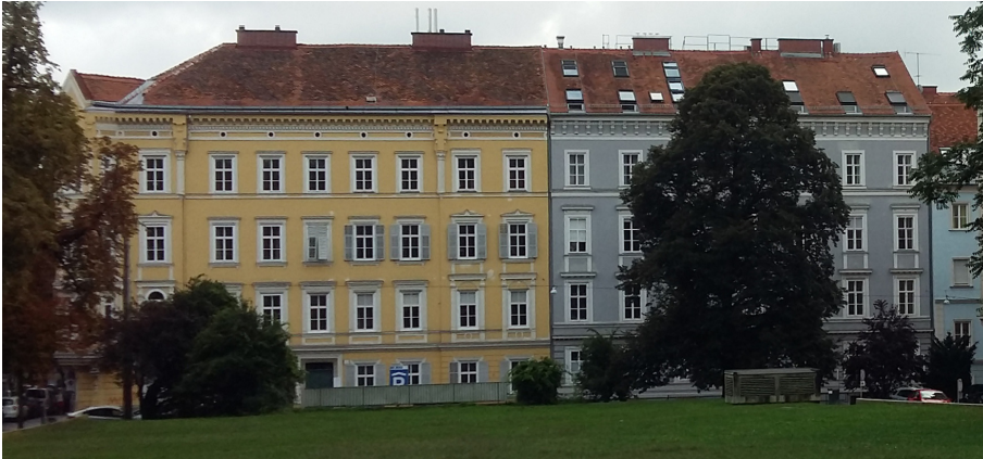
Bild 2.1 Negativbeispiel Dachflächenfenster Einspinnergasse
