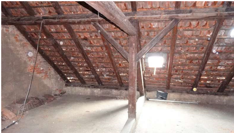
Bild 2.11 Gespärre eines typischen Gründerzeitdachstuhls 31
