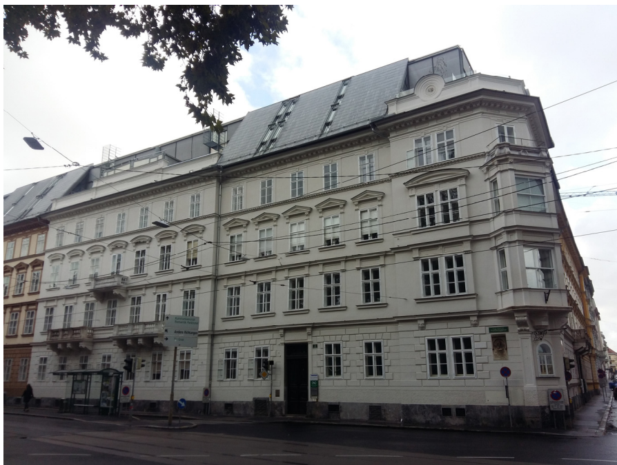
Bild 2.3 Dachgeschossausbau am Glacis von Klaus Kada
