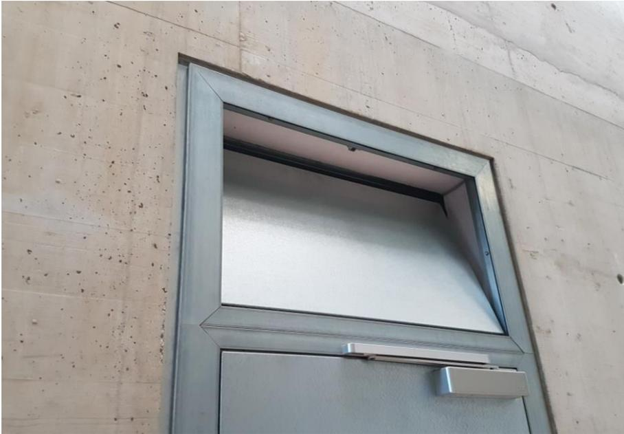
Bild 3.2 Lüftungsklappe im Türsturz der Innentüren
