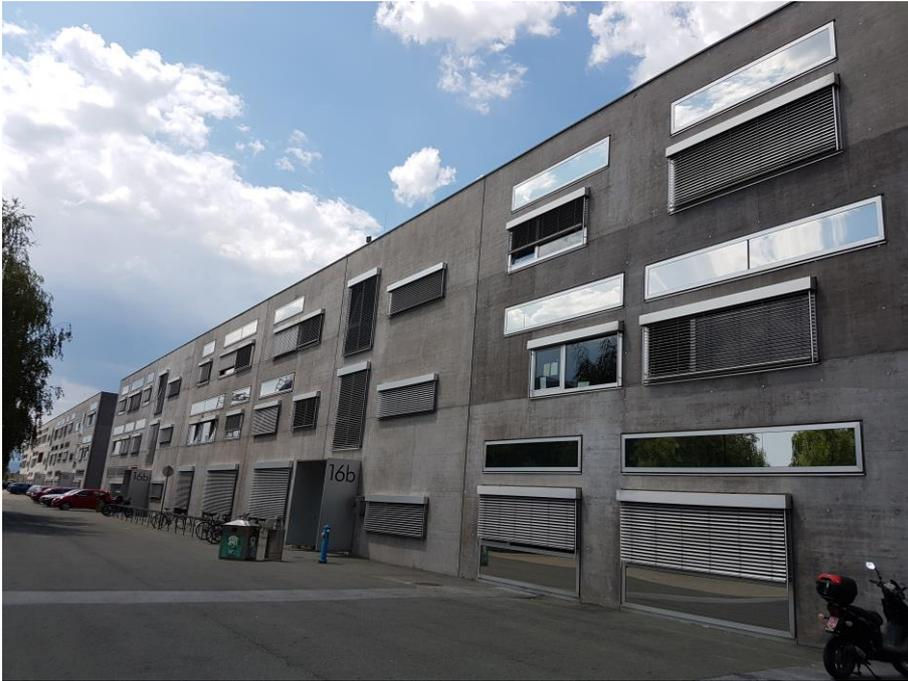
**Bild 3.9 Fassade des Gebäudes Inffeldgasse 16b mit außenliegender Beschattung**
