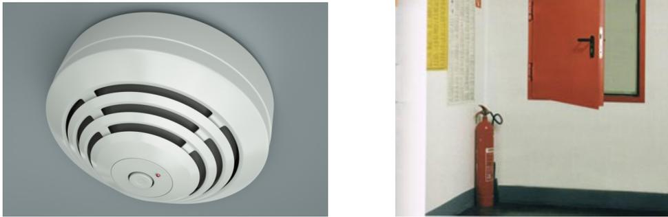
Abb. 1.1: Brandmelder [3] (links), Brandschutzklappe [4] (rechts)
