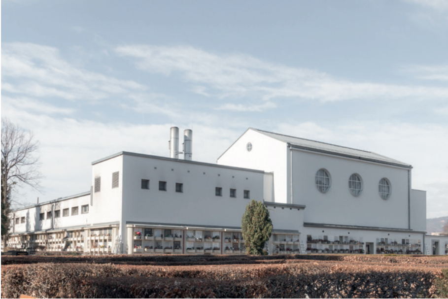
Südost-Fassade der bestehenden Feuerhalle und Teil des Urnenfriedhofs
