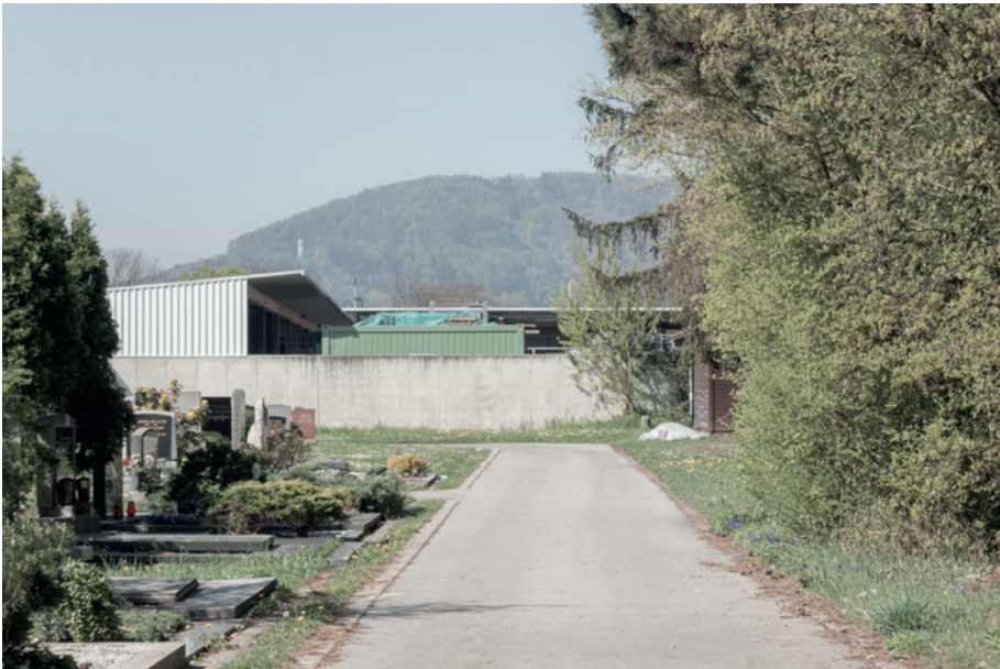
Blick vom Zentralfriedhof Richtung Westen zum Bauplatz
