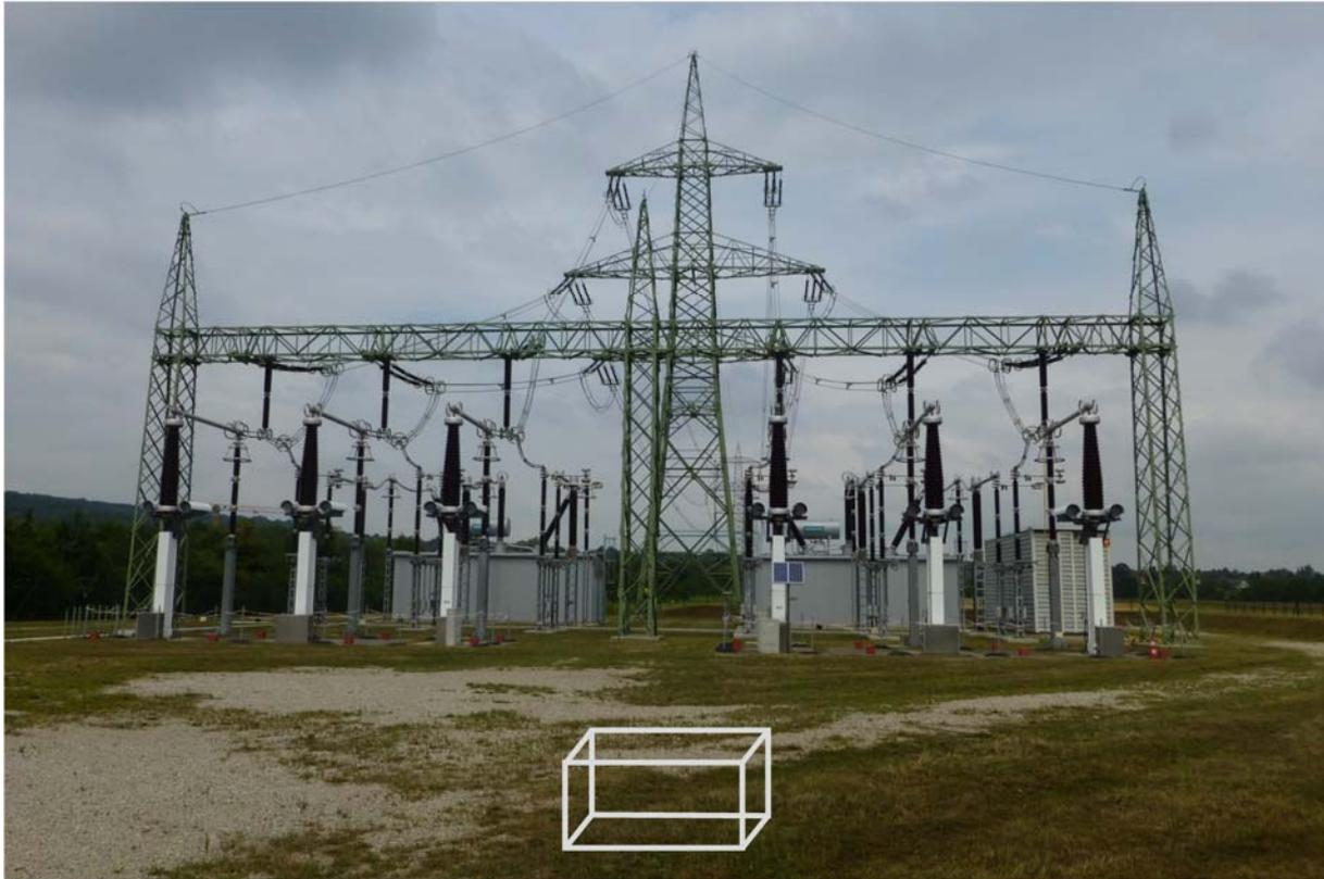
**Abbildung 4-10: Ansicht eines Kabel auf Freileitung Übergangportals (KÜ-Portals) mit Größenvergleich eines Muffenbauwerks**
