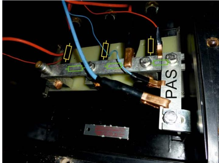
Abbildung 3-6: Erdungsbox einer Muffenstelle eines 400-kV-Kabelsystems, 3 Kabelschirme direkt geerdet, Messung eines Kontaktübergangswiderstandes
