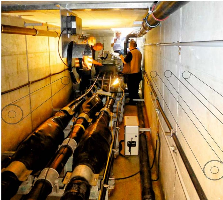
**Abbildung 5-28: Beengte Platzverhältnisse innerhalb eines Muffenbauwerks einer 400-kV-Kabelleitung (gezeichnete Leiter symbolisieren mögliche benachbarte Kabelleitungen, hinter der Betonwand)**
