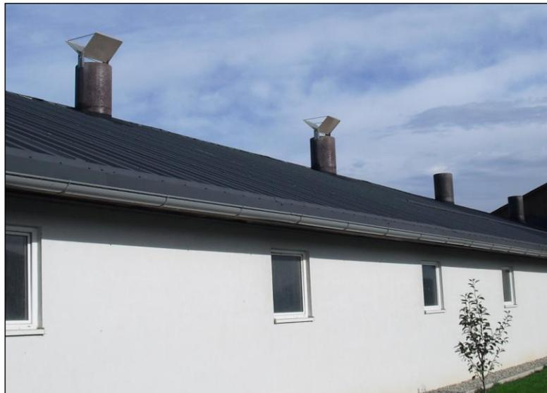
**Abbildung 6.3:** Regenschutzhauben (links) an Abluftrohren des Betriebes F2
