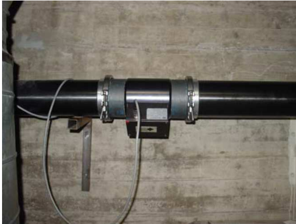
Abbildung 2-14 Sensoreinheit Sensy-flow in der Messstrecke und schematisches Funktionsprinzip [2]
