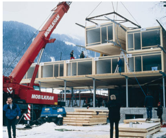
Abb. 85 | Raummodule Holz Hotel Post Anbau
