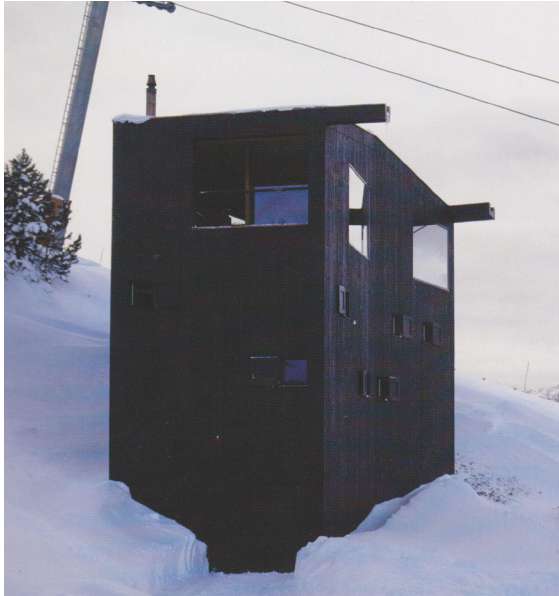
Abb. 22 | Blick von Südosten
