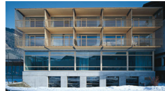
Abb. 86 | Raummodule Holz Hotel Post Anbau
