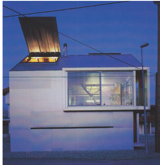
Abb. 16 | Blick Außen von Westen
