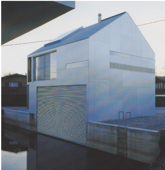
Abb. 15 | Blick Außen von Nordost
