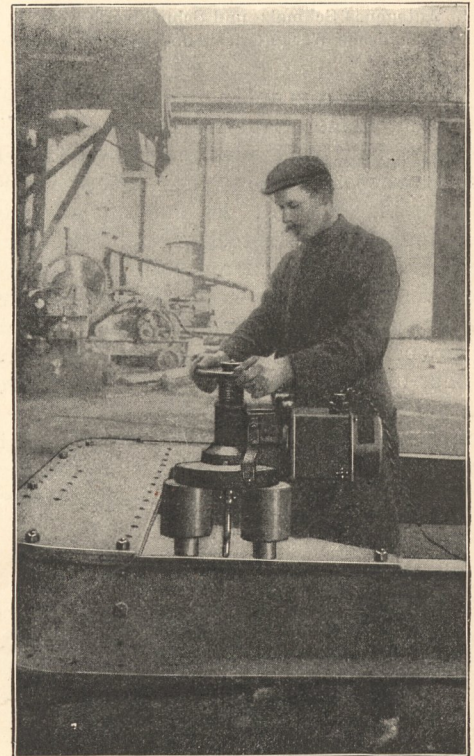
Fig. 478. Elektromagnetische Bohrmaschine, System Burckhardt. Ausführung: C. & E. Fein, Stuttgart.
