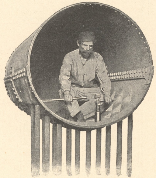
Fig. 97. Einwalzen der Rohre in Garbe-Kessel.
