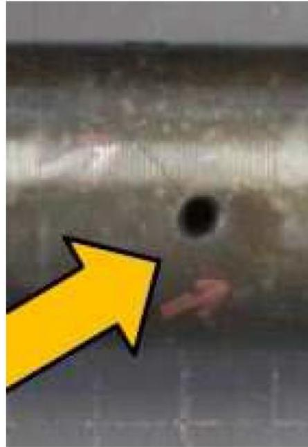
*Abbildung 3: Schmierbohrung*
