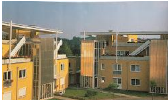
Abbildung 78 Aussenansicht Wohnanlage Stainz
