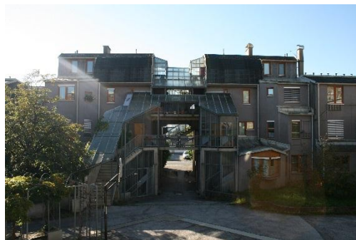
Abbildung 43 Situation Eingangsbereich, hofseitig
