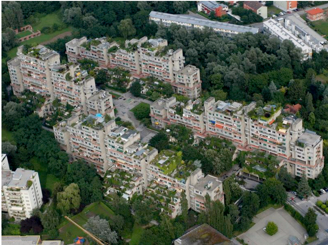
Abbildung 20 Luftbild Terrassenhaussiedlung, Graz, 2005
