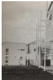
Abbildung 90 Ansicht hofseitig, Wohnbau Peggau
