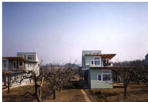
Abbildung 91 Ansicht Wohnbau Apfelbaumgarten
