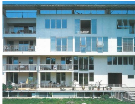
Abbildung 60 Aussenansicht Wohnbau Carl-Spitzweg-Gasse
