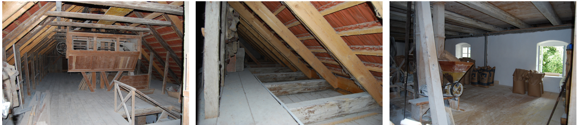
Abb. 80 Bestandsfotos des ungedämmten Dachstuhls (links und Mitte), ungedämmte Decke im Obergeschoss zum Dachstuhl (rechts)
