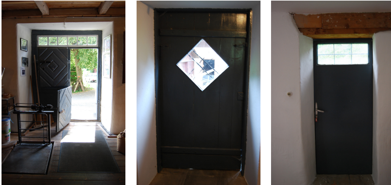
Abb. 82 Bestandsfotos der Außentüren im EG (links), im Zwischengeschoss (Mitte) und im Obergeschoss (rechts)
