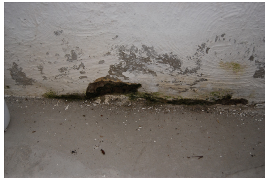
Abb. 79 Bestandsfotos der Schäden des Mauerwerkes im Raum 03
