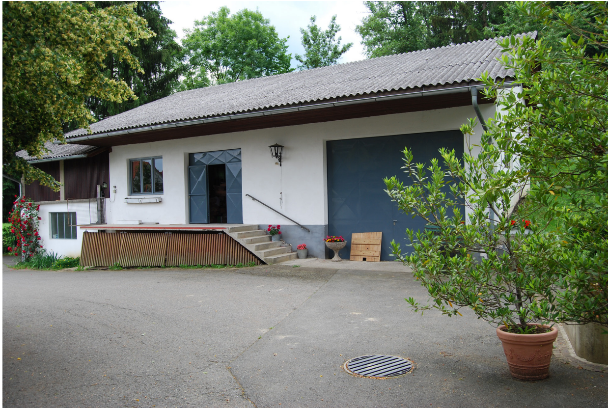
Abb. 43 Lagerhalle für Schrot und Mehl
