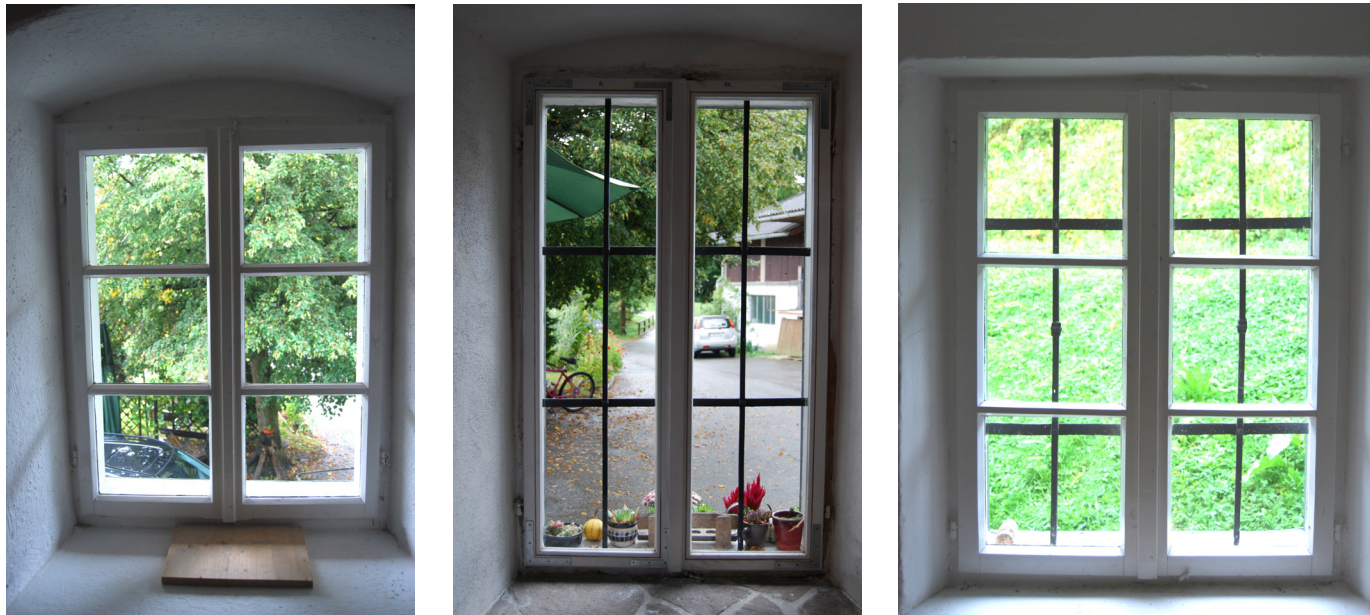
Abb. 81 Bestandsfotos der unterschiedlichen Fenstertypen von innen
