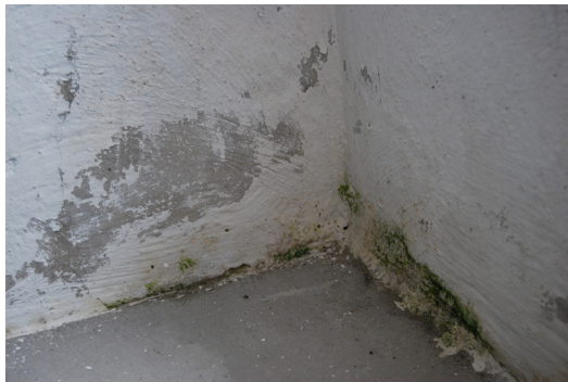
Abb. 79 Bestandsfotos der Schäden des Mauerwerkes im Raum 03
