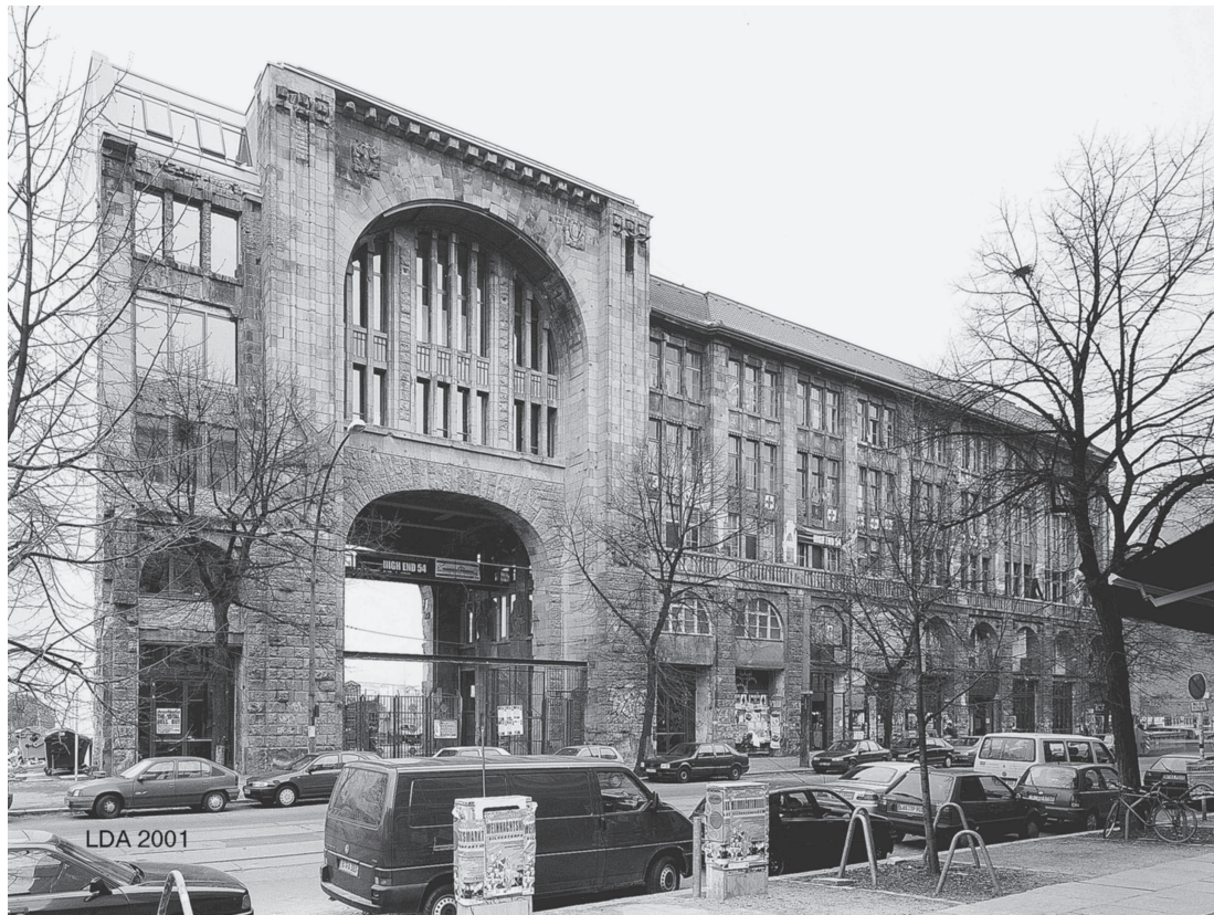
Abb. 11: Ehemalige Friedrichstraßenpassage & Haus der Technik & Kunsthaus Tacheles. © Foto: Landesdenkmalamt Berlin, 2001.
