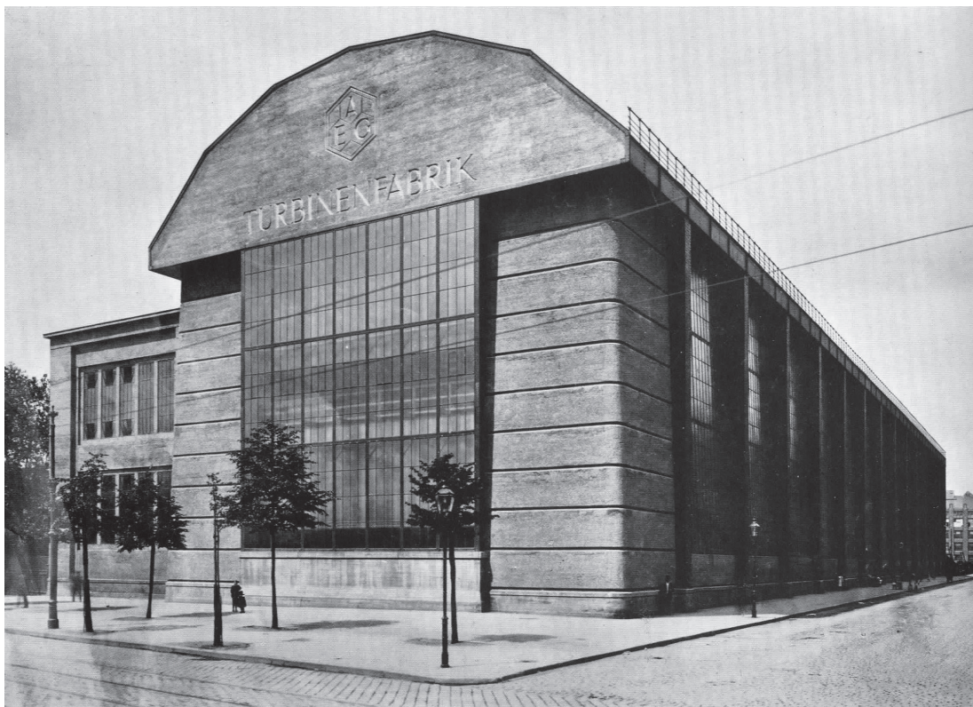
Abb. 4: Peter Behrens, Montagehalle der AEG Turbinenfabrik © Tilmann Buddensieg, Berlin 1981.
