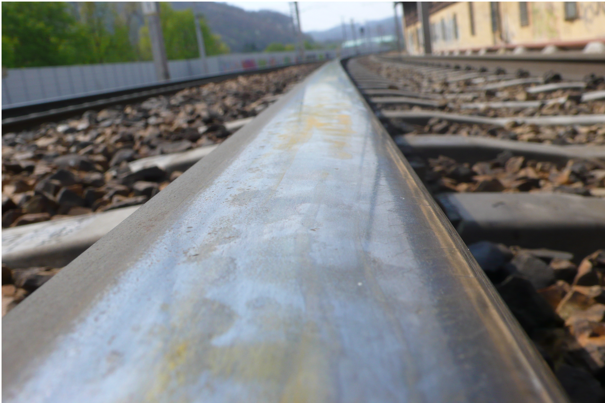
Abbildung 6.62: Fahrspiegel an der Strecke in der Nähe von Velden am Wörthersee
