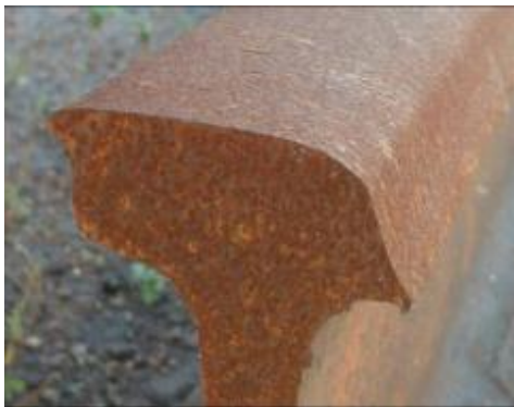
(a) Beispiel für eine sehr stark verformte und verschlissene Schiene [7]
