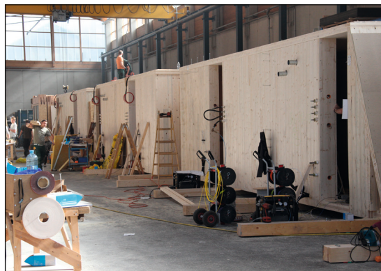
Abb. 119: Vorfertigung von BSP-Raumzellen in der Werkshalle | Kaufmann Bausysteme, 2018
