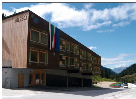
Abb. 99: Raumzellenbau aus BSP | Architektur: Holzbox a, b Errichtung des Prototyps, 2003 c Apartmentanlage Planneralm, 2005
