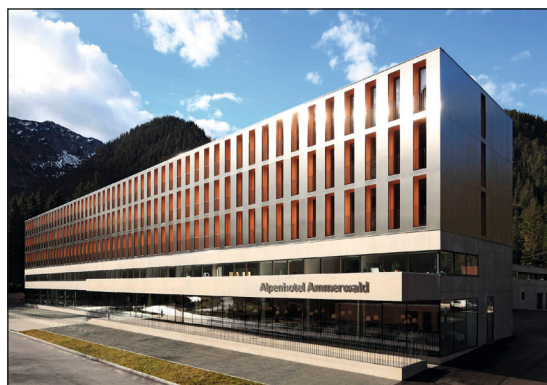
Abb. 97: Raumzellenbauten aus BSP | O. L. Kaufmann u. A. Rüb a, b 2. Zubau Hotel Post, 2009 c, d Hotel Ammerwald, 2009
