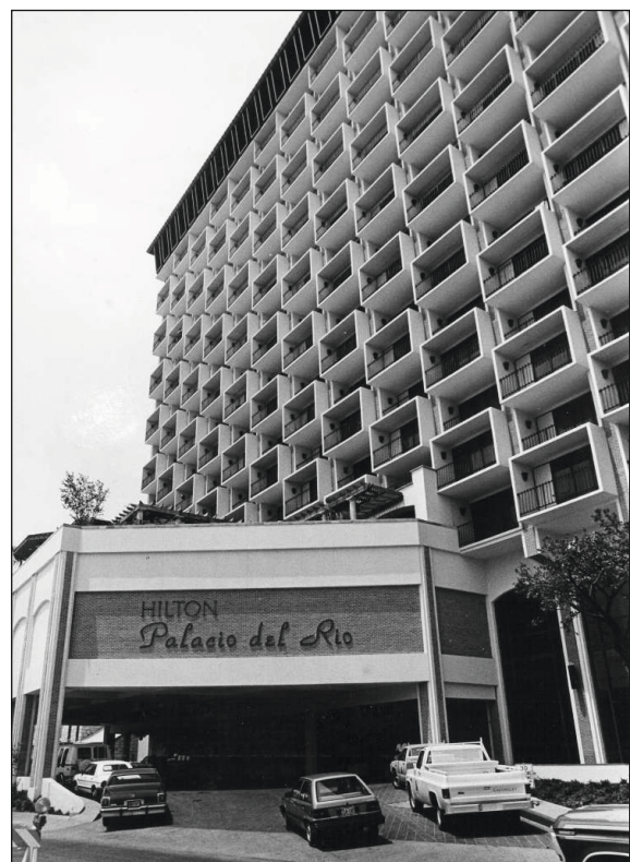
Abb. 62: The Hilton Palacio del Rio Hotel in San Antonio, Texas, USA | Architektur: Cerna & Garza Architects | Ausführung: H. B. Zachry Company 1967-1968 a, b Platzieren der Raumzellen während der Bauphase c Aufnahme des fertigen Gebäudes
