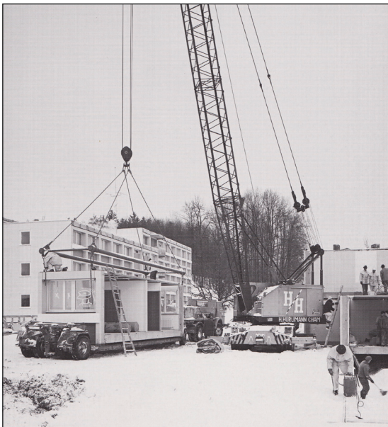
Abb. 69: a-d Raumzellenbau mit dem Variel-Beton-System von Fritz Stucky
