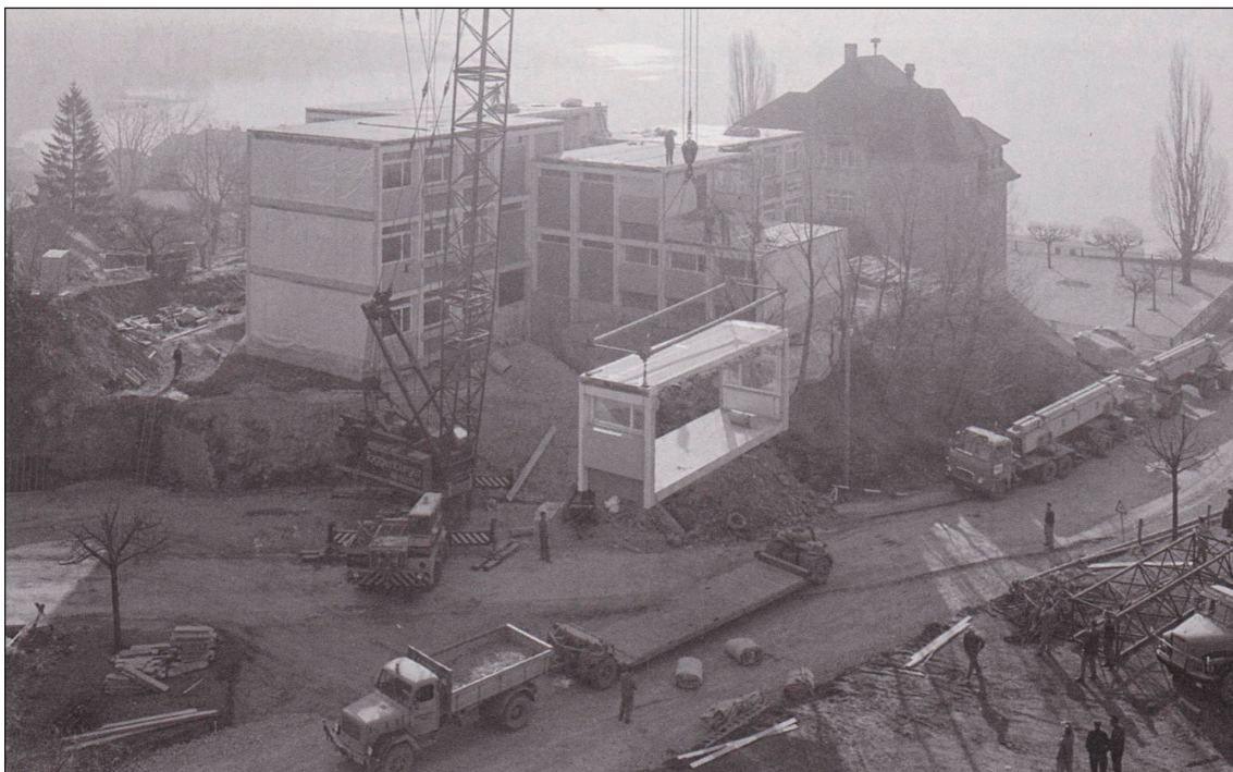
Abb. 77: Schulhaus in Hauterive, Schweiz 1968 | Versetzen einer Raumzelle auf der Baustelle
