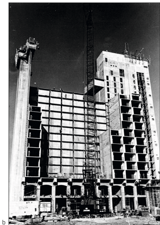
Abb. 62: The Hilton Palacio del Rio Hotel in San Antonio, Texas, USA | Architektur: Cerna & Garza Architects | Ausführung: H. B. Zachry Company 1967-1968 a, b Platzieren der Raumzellen während der Bauphase c Aufnahme des fertigen Gebäudes
