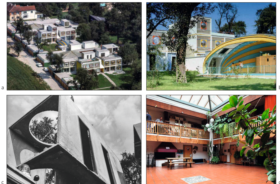
Abb. 63: a Luftaufnahme der ersten Anlage der "Palétuviers", Baujahr 1975, Leonding, OÖ b Die zwei benachbarten Atriumhäuser in Leonding wurden durch ein gemeinsames Schwimmbad verbunden. c Versetzen einer Raumzelle aus Leichtbeton auf der Baustelle in Leonding d Das Atriumhaus in Raaba bei Graz wurde 1978 ebenfalls in Raumzellenbauweise errichtet.
