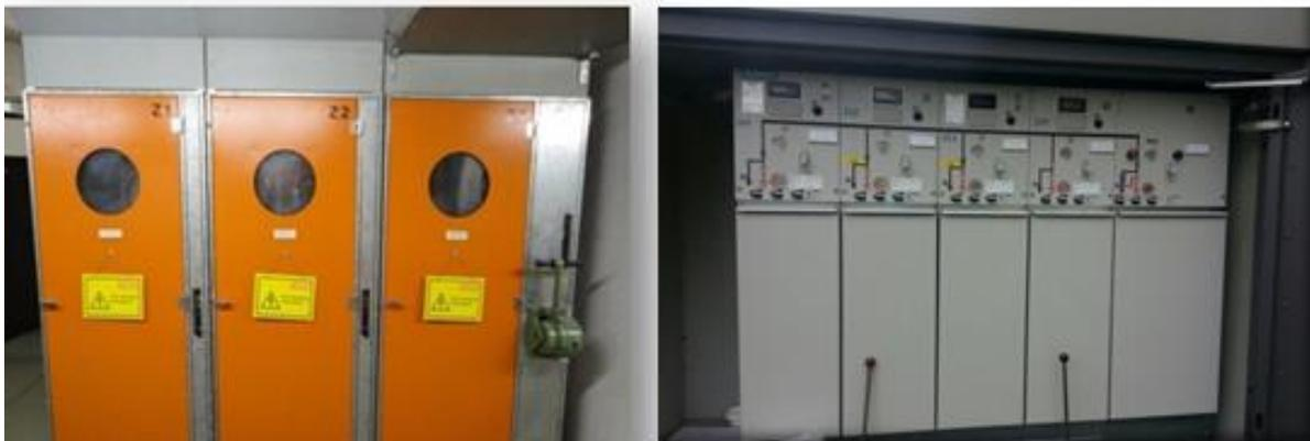
Abbildung 45 Unterschiede in der Schaltanlagenbauform in Trafostationen
