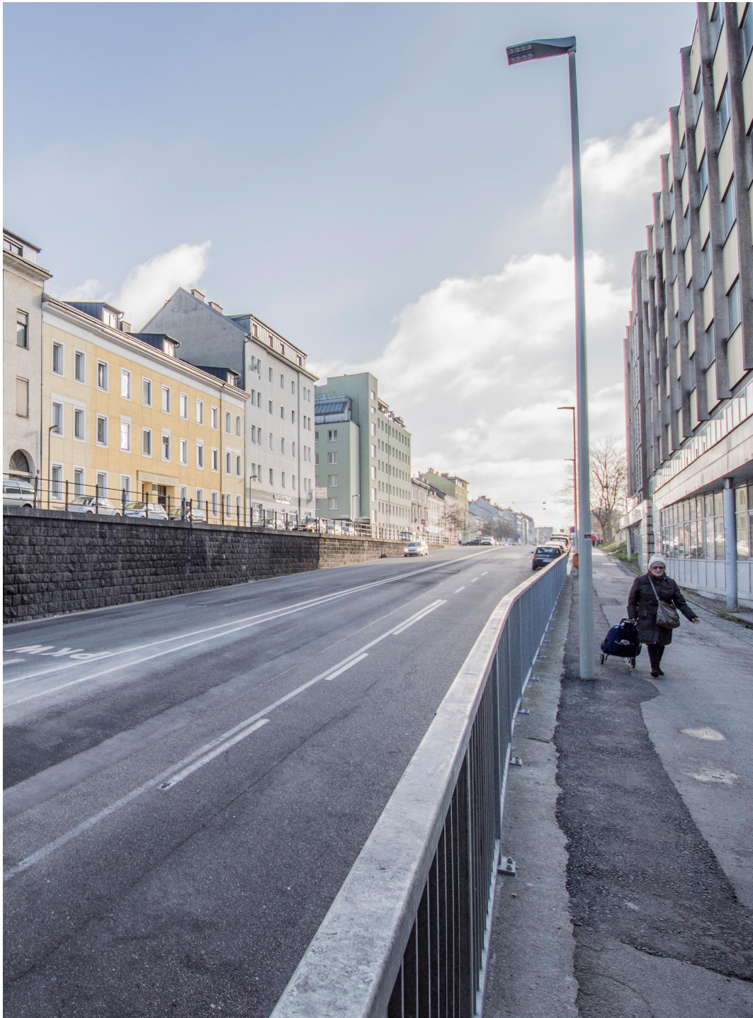
Abb. 19 Blick in Richtung Süden, unter der Unterführung, 2017
