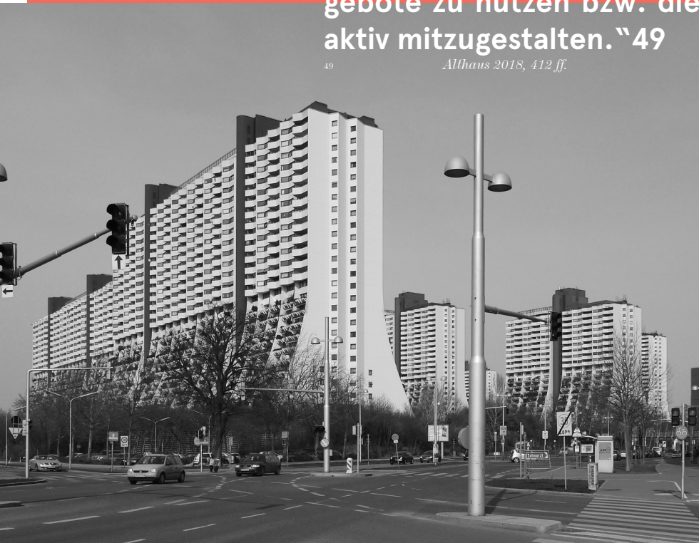
Abb. 7: Großwohnsiedlung Alt Erlaa, Wien
