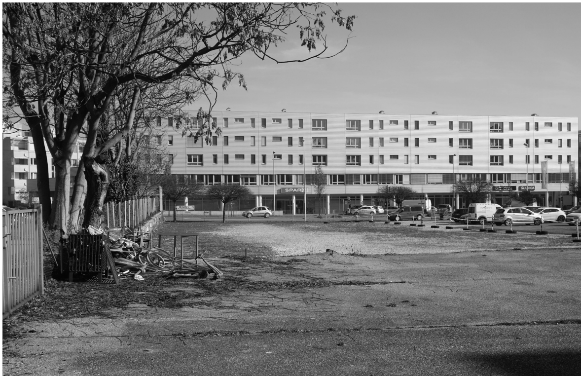
Abb. 26: Bauplatz | Blick nach Osten
