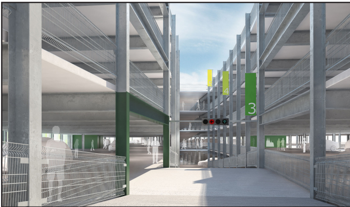
Abb. 29: Rampe Abfahrt P22a
