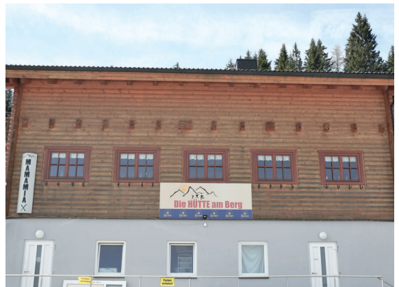
ABB. 47: Standort 2 „Die Hütte am Berg“ Seitenansicht
