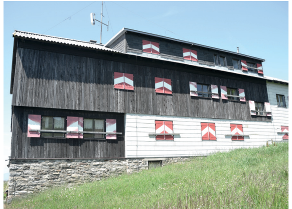
ABB. 51: Standort 3 Ostansicht Bestandsgebäude
