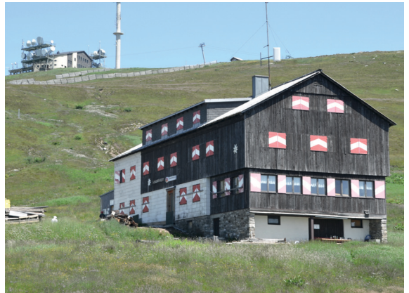
ABB. 53: Standort 3 Bestandsgebäude Süd-Westfassade
