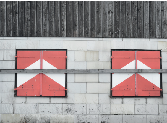
ABB. 56: Standort 3 Detail Westfassade
