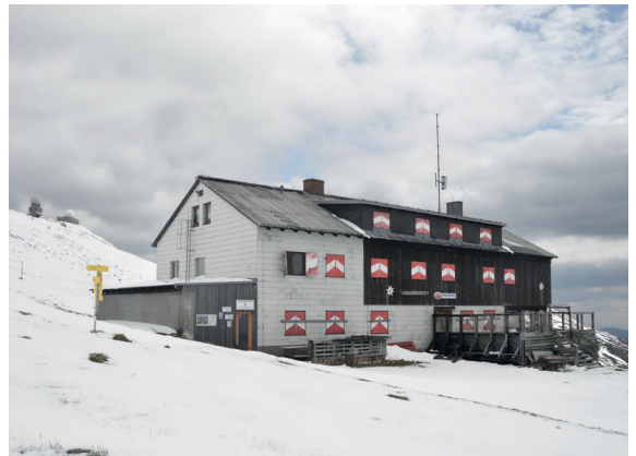
ABB. 61: Standort 3 Nord-Westansicht Bestandsgebäude
