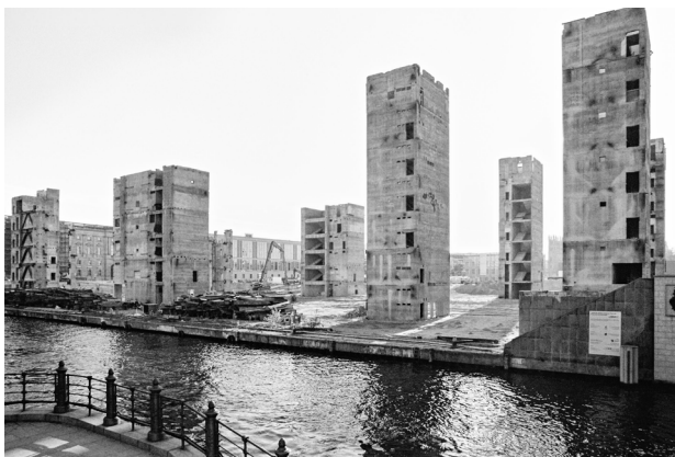
Abb. 70 Abriss des Palastes der Republik Berlin 2006-2008
