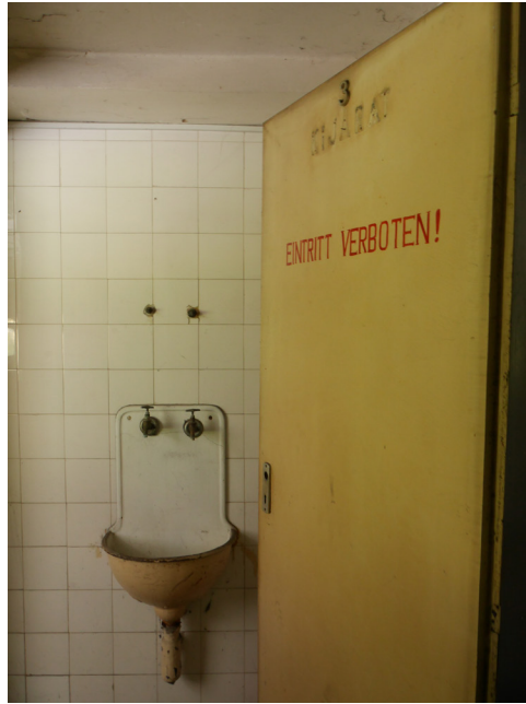
Abb. 51 Zugang zum Kontrollgang 1.OG
