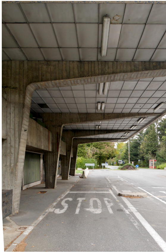
Abb. 48 ehemaliges Zollamt Köszeg, Nov. 2018
