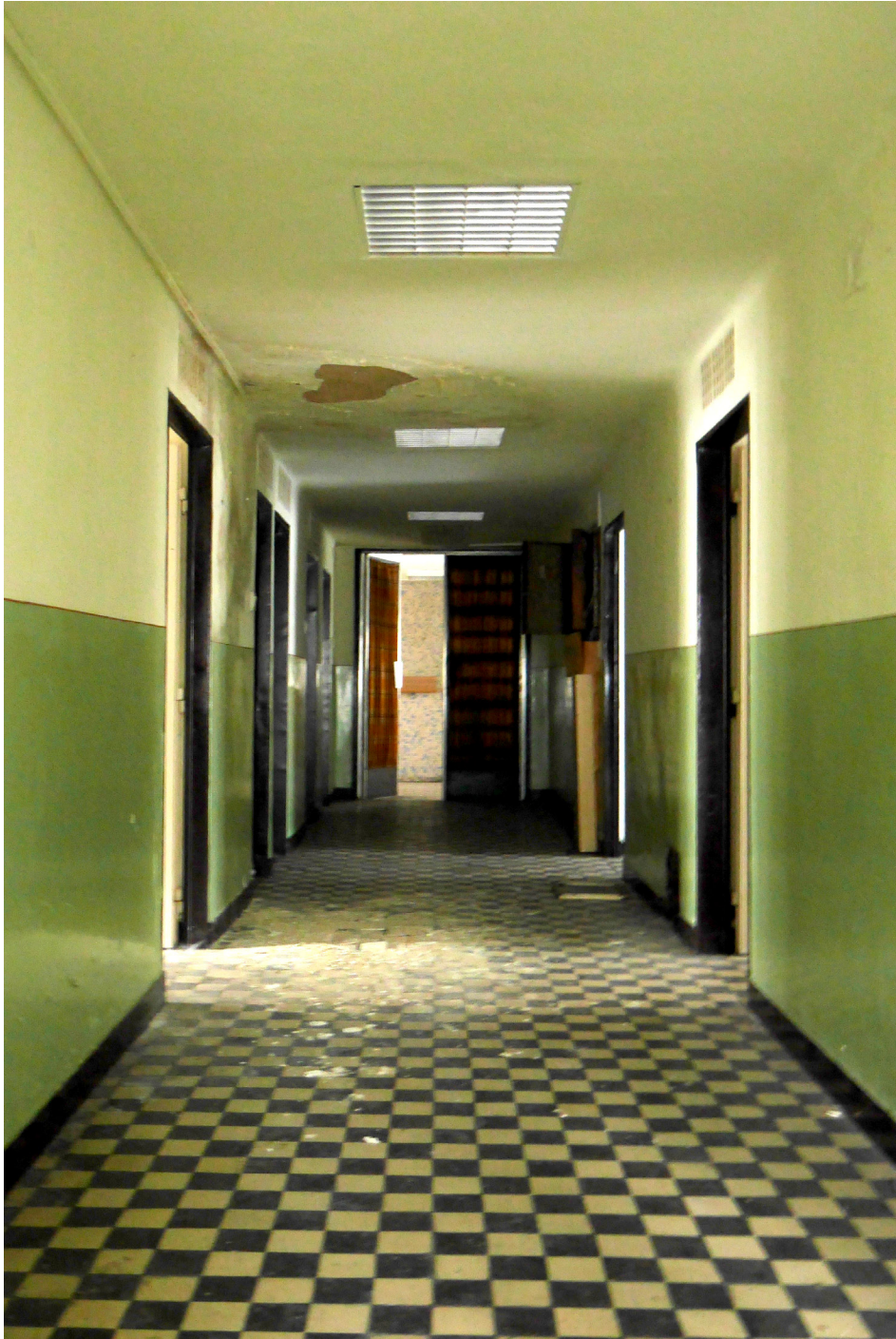
Abb. 56 Mittelgang, Blick ins Foyer
