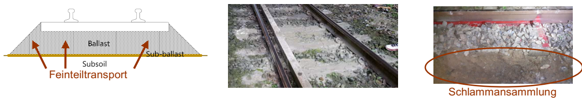
Abb. 1: „Mud Pumping“ (Kuo et al., 2016)
