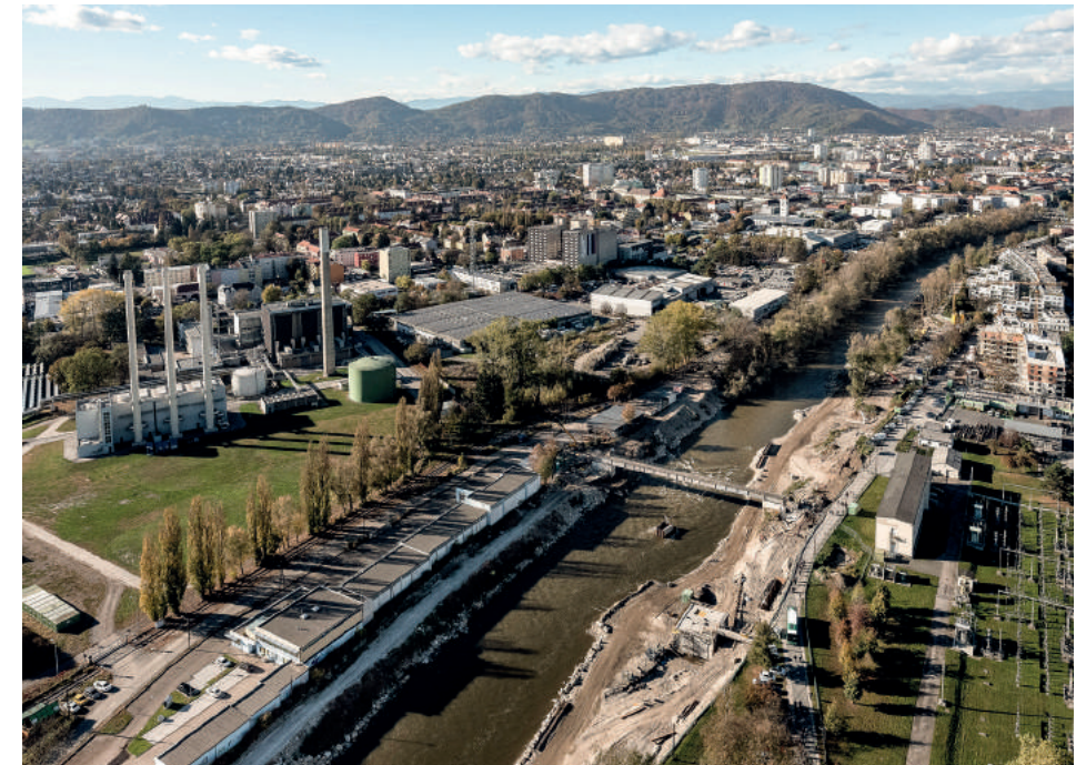
Blick Richtung Norden auf Fernheizwerk, Mediensteg
