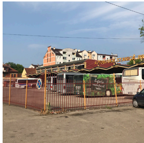
4 Abb. 41 Busbahnhof mit Stabstahlzaun gesichert
