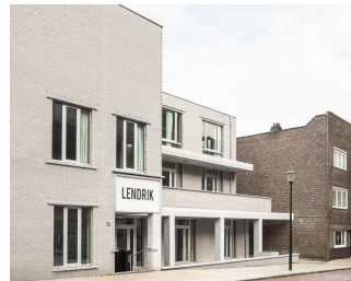
Abb.25: Ansicht außen III
