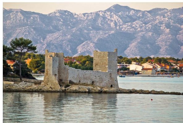
17 Aufnahme der ‚Kastelina‘ Festung nach der Restaurierung.
